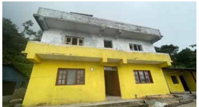
फोटो नं १ अधिकृत आवासगृह (पोष्ट भवन) निर्माण।
