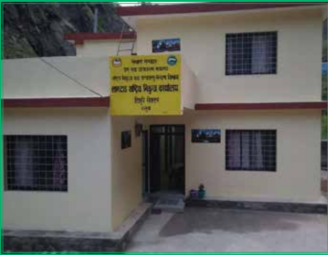
एनसेल प्रा.लि. बाट निर्माण सम्पन्न भएको टिमुरे सेक्टर कार्यालय
