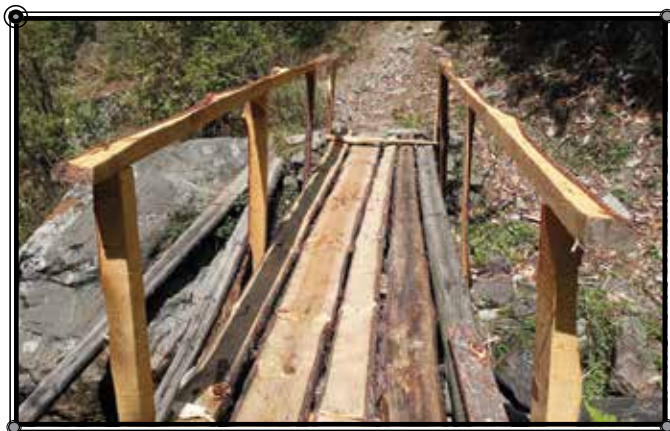
काठेपुल निर्माण, भार्खु
