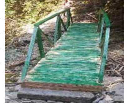
फोटो नं. ५ काठेपुल निर्माण लाङटाङ रुट ।
