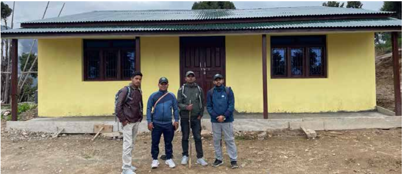
फोटो नं १ चोलाडपाटी पोष्ट भवन निर्माण ।
